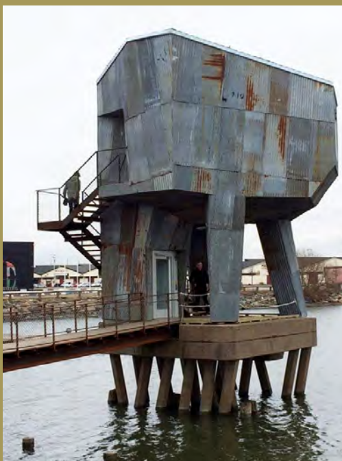
#göteborg Platsbyggnad i Frihamnen. Vi skapar första etappen av bebyggelse och jubileumspark inför stadens 400-årsjubileum tillsammans med engagerade göteborgare från hela staden. Fritt fram att vara med och bygga. Öppet för världen!
